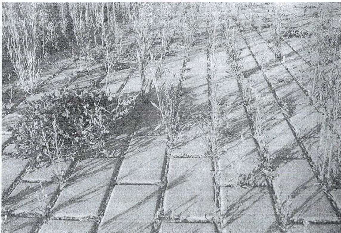
Rysunek 2. Utrzymanie dróg dla rowerów z kostki wymaga starannego usuwania roślinności ze szczelin pomiędzy kostkami. Przejście DK 61 przez Bargłów Kościelny.
