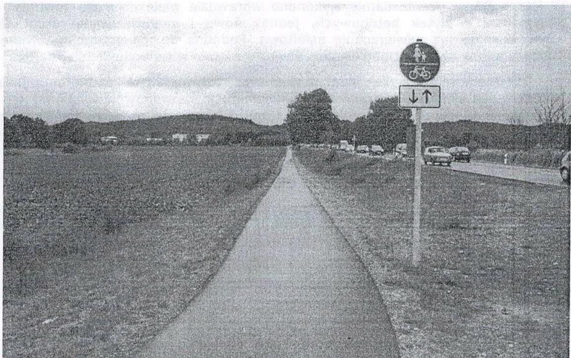
Rysunek 8. Nowe drogi dla rowerów i ciągi pieszo-rowerowe w Niemczech wykonywane są w technologii nawierzchni asfaltowej. Na zdjęciu droga federalna nr 158 w okolicy Bad Freienwalde.
