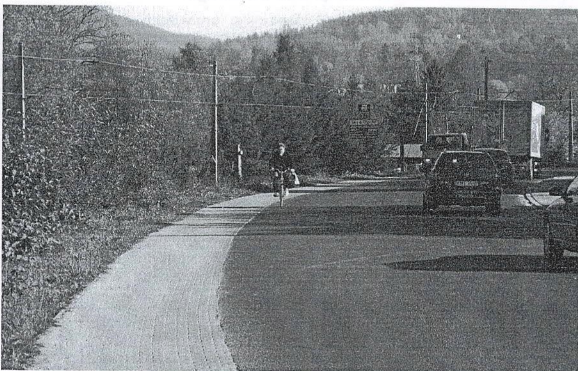
Rysunek 9. Tam, gdzie drogę dla rowerów wykonano z kostki betonowej, rowerzyści często pozostają na jezdni. DW 958 w okolicy Rabki.
