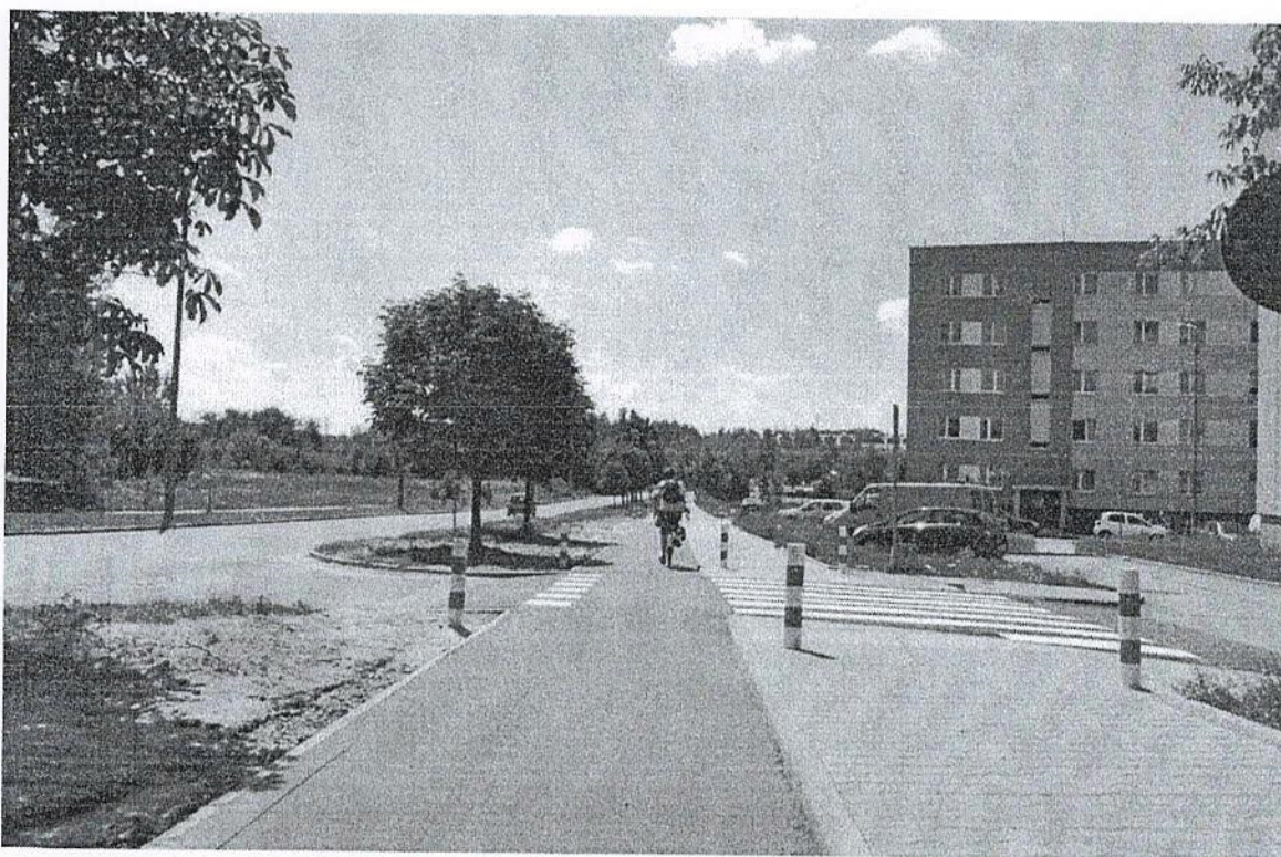
Rysunek 10. Wzorcowa nawierzchnia drogi dla rowerów z zachowaniem ciągłości na przejeździe przez wlot ulicy lokalnej. Radom, ul. Sycyńska. Fot. Rafał Muszczyński, www.zm.org.pl
